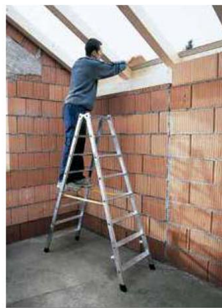
Trap met gefelste treden, tweezijdig beklimbaar (zie pag. 52)
