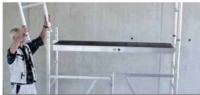
Stap 5: opbouwframe aanbrengen
