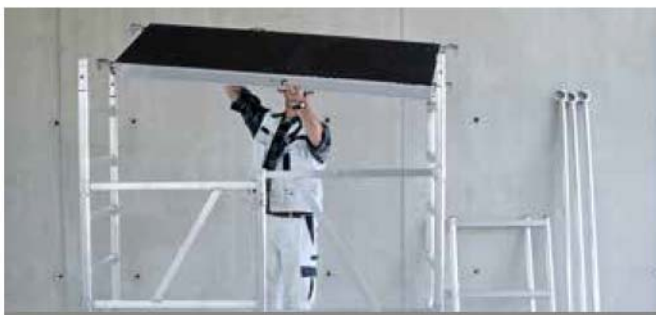
Stap 4: Inhangen van het platform
