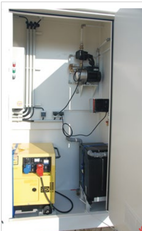
Techniek ruimte met ventilator, schakelkast en noodstroomaggregaat
